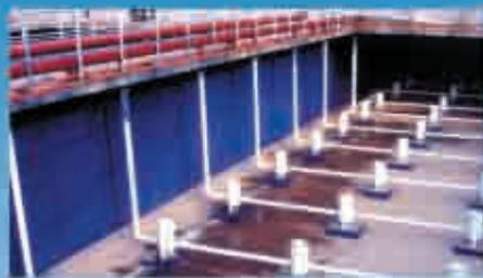
聚脲喷涂防腐的工业废酸废水池
